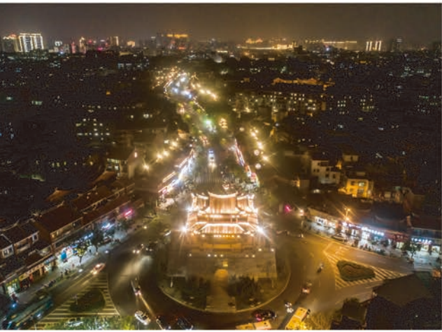
▲ 方圆建设集团承建的泉州市区重要节点夜景工程
